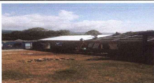
Foto 3: Se Observa la instalación de estructura y lámina.
