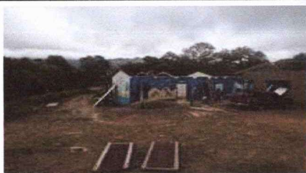
Foto 1: Se observa el trabajo del desentechado de moludo 2, para la sustitución de estructura de techo y láminas.
