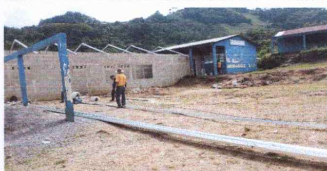
Foto 6: Se observa la colocación de estructura de techo en el modulo 1 y en el corredor del modulo 2.
