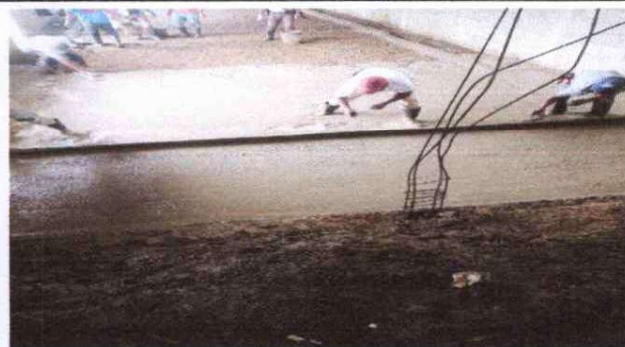
Foto 4: Se observa la instalación de piso de concreto de cemento.
