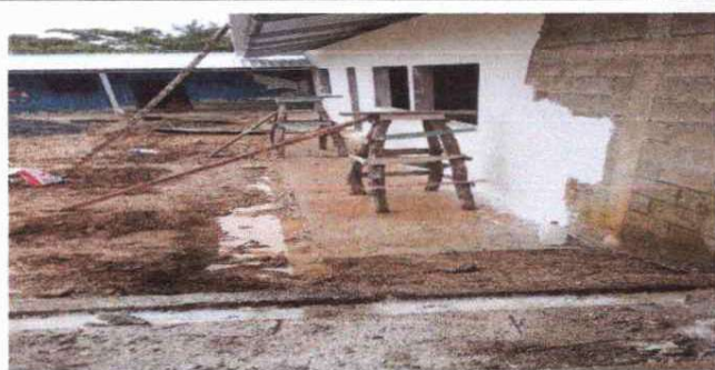
Foto 5: Se observa la colocación del repello en la pared exterior del modulo 1
