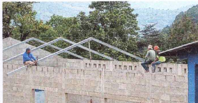
Foto 2: Se observa la rehabilitación de la estructura de techo en el modulo 1
